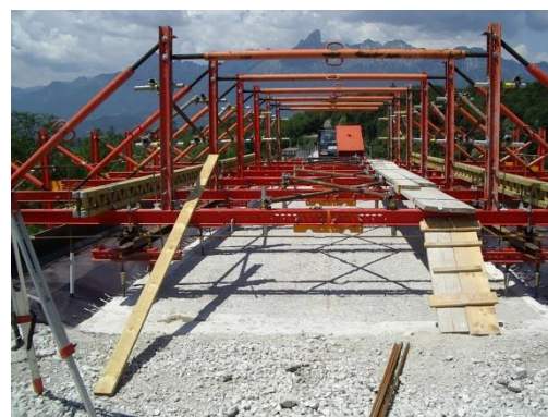
Ponte di San Felice sul fiume Piave: Vista del cassero dall'alveo e dall'estradosso
