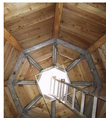
Torre Bissara: veduta da Piazza delle Erbe, particolare della cerchiatura del tamburo e interno del nuovo cupolino
