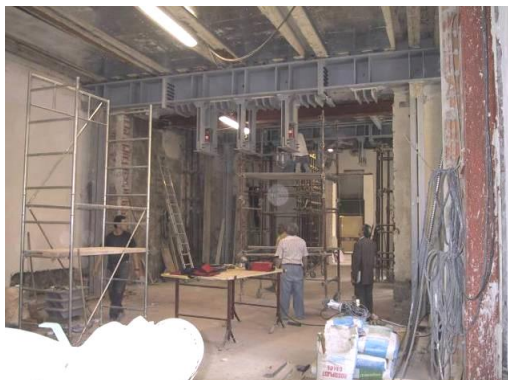
Palazzo Treves a Verona: posa in opera dei nuovi portali in acciaio e particolare dei martinetti di carico
