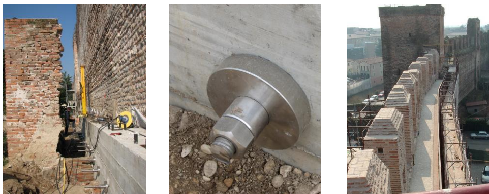
Mura di Cittadella (PD): particolari del rinforzo in fondazione e vista del camminamento da un torrino
