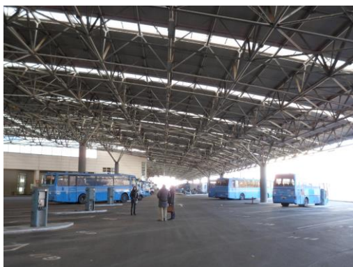
Nuova sede Atesina (Roncafort - TN): Stalli per gli autobus con copertura metallica e palazzina uffici in c.a.p.
