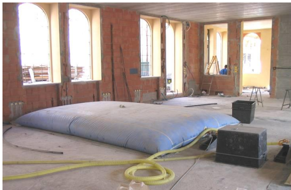
Ex Opificio Baggio presso Marostica (VI): prova di carico dei solai in latero cemento
