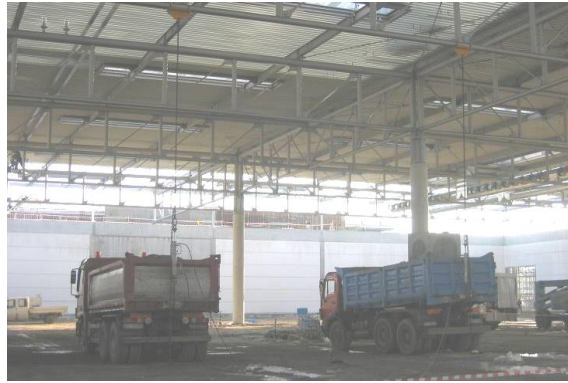
Fiera di Verona: prova di carico della struttura di copertura dei nuovi padiglioni
