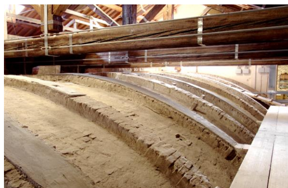
Copertura S. Corona: interventi di rinforzo delle capriate lignee e delle volte
