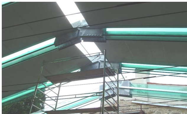
Loggia dei Vicari presso Arquà Petrarca (PD): posa in opera della nuova copertura
