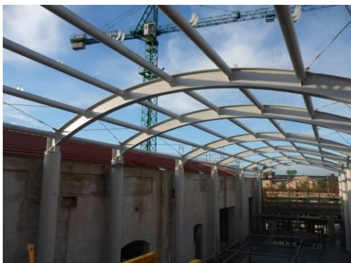
Magazzino 1 degli Ex Magazzini Generali a Verona: Vista della copertura metallica della galleria e delle nuove capriate lignee
