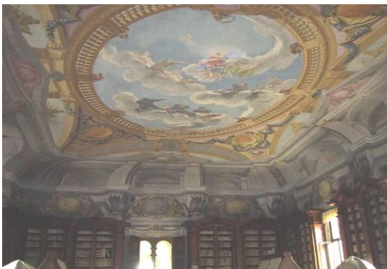
Biblioteca Antoniana: intradosso del soffitto affrescato e scorcio della nuova struttura di sostegno in lega di alluminio
