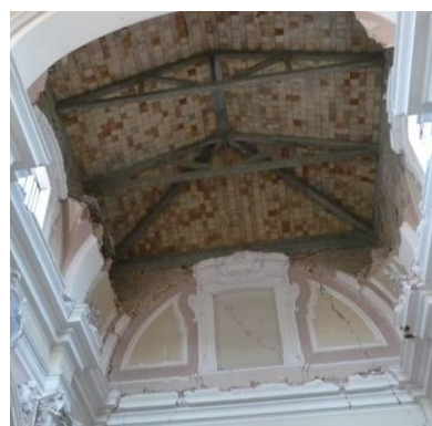
Chiesa di S. Domenico a L'Aquila: puntellazione sulla facciata del transetto e crollo della volta della navata laterale
