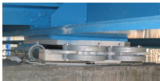
Viadotto di Silea: vista dall'intradosso a lavori in corso e dettaglio di un dispositivo di appoggio e dissipazione sismica
