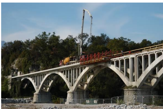
Ponte di San Felice sul fiume Piave: Vista del cassero dall'alveo e dall'estradosso
