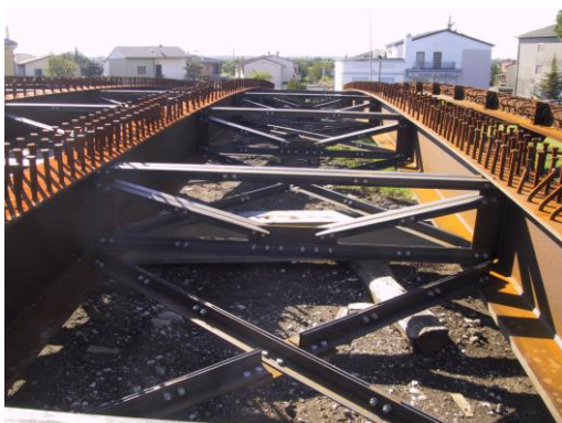
Ponte di Costalunga: vista frontale dell'impalcato metallico prima del varo e del ponte a lavori finiti
