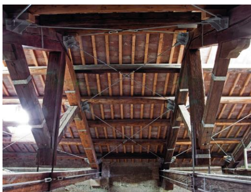
Copertura S. Corona: interventi di rinforzo delle capriate lignee e delle volte
