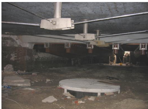
Arena di Verona (VR): sottostruttura metallica per la soletta della grande fossa e panoramica della copertura lignea del Golfo Mistico
