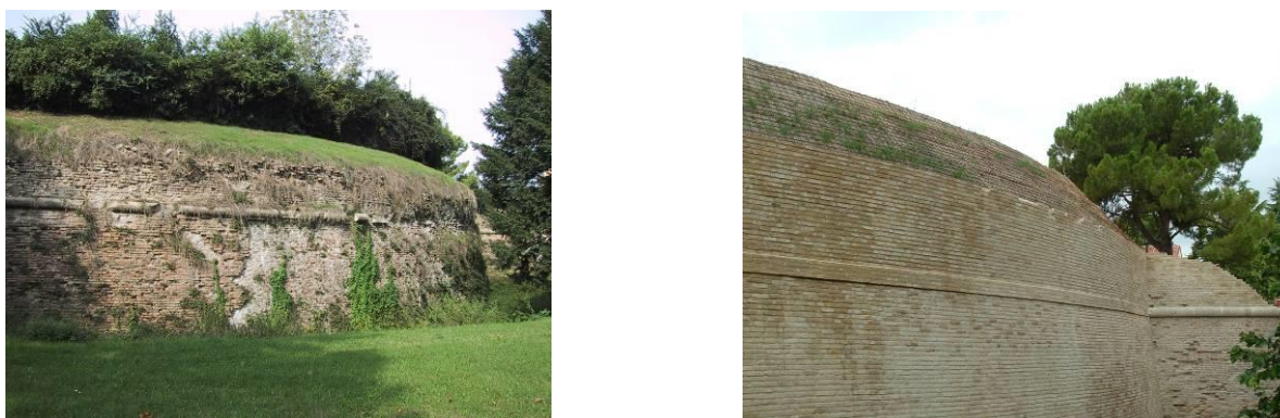
Bastione S. Giustina (PD): scorcio del paramento esterno prima e dopo gli interventi di restauro
