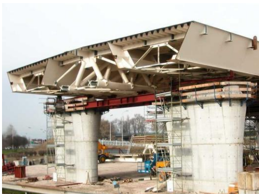
Viadotto "Torri di Quartesolo": particolare del varo a spinta e vista a lavori ultimati
