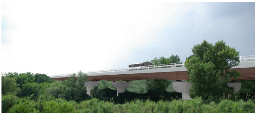
Foto inserimento del ponte sul fiume Piave lungo l'autostrada A4
