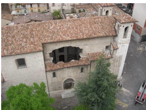
Chiesa di S. Marco a L'Aquila: vista della chiesa con porzione di navata laterale crollata e interno
