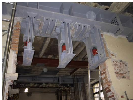
Palazzo Treves a Verona: posa in opera dei nuovi portali in acciaio e particolare dei martinetti di carico
