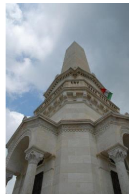
Ponteggi in fase di cantiere e vista a lavori ultimati
