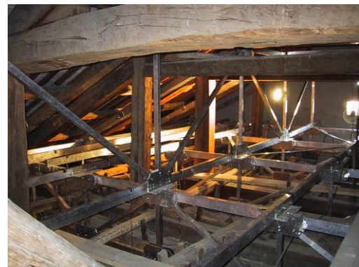
Biblioteca Antoniana: intradosso del soffitto affrescato e scorcio della nuova struttura di sostegno in lega di alluminio
