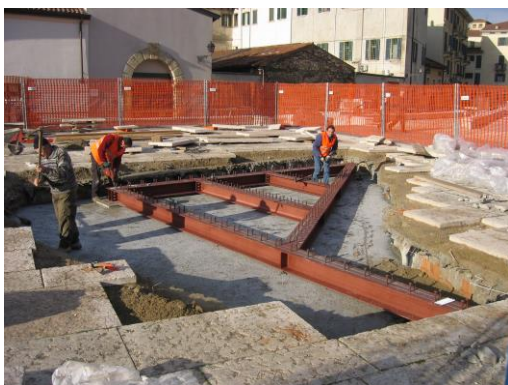
Carpenteria metallica del basamento e vista del monumento a lavori ultimati
