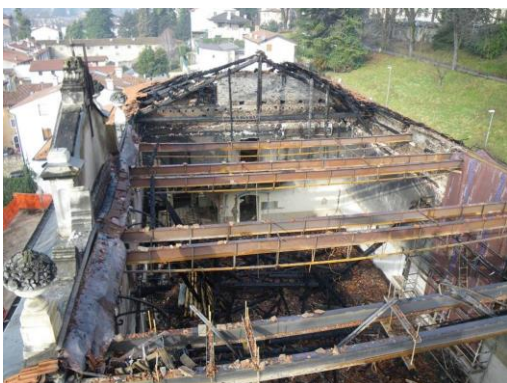
Asilo Rossi di Schio: copertura dopo l'incendio e cordolo in muratura armata
