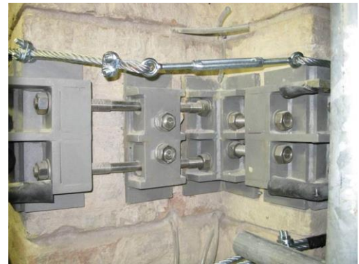
Intervento di cerchiatura attiva dei pilastri: particolare esecutivo e realizzazione
