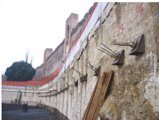
Nuovo parcheggio di Cittadella (PD): Fase di realizzazione dei diaframmi e particolare della tribuna lignea sulla piazza di copertura
