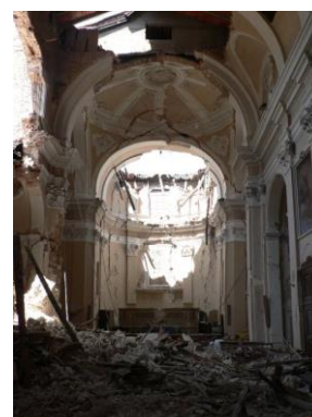
Chiesa di S. Marco a L'Aquila: vista della chiesa con porzione di navata laterale crollata e interno
