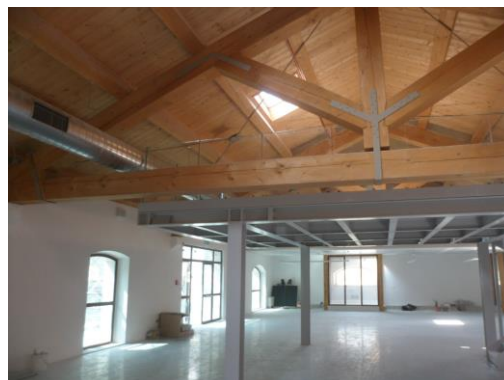
Magazzino 1 degli Ex Magazzini Generali a Verona: Vista della copertura metallica della galleria e delle nuove capriate lignee
