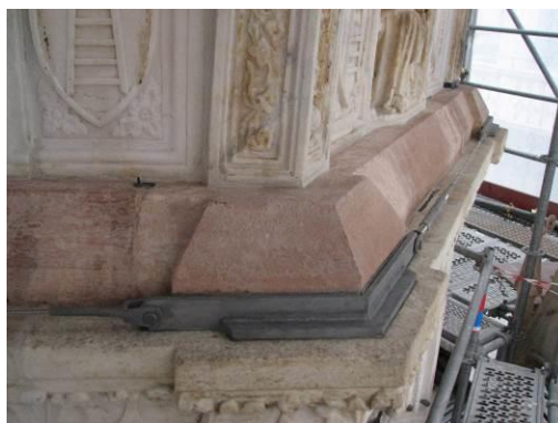
Arca di Cansignorio (VR): stato tensionale da modello F.E.M., particolare di una cerchiatura e vista a lavori finiti
