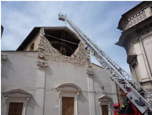
Chiesa di San Biagio d’Amiterno: crollo parziale della facciata e modello numerico
