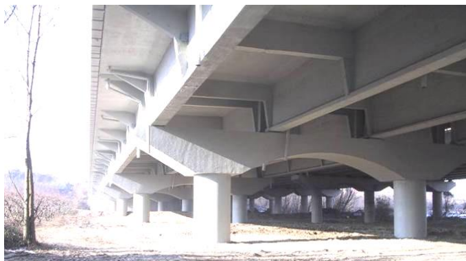
Ponte sul fiume Adige: vista dell'intradosso a lavori ultimati
