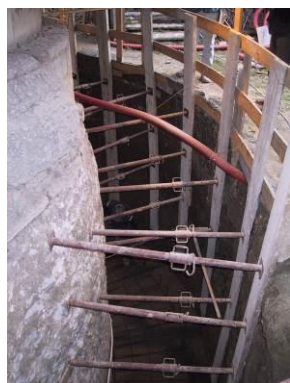
S. Giovanni in Valle (VR): realizzazione d'intercapedine per le fondazioni e vista di torre campanaria e abside a lavori ultimati
