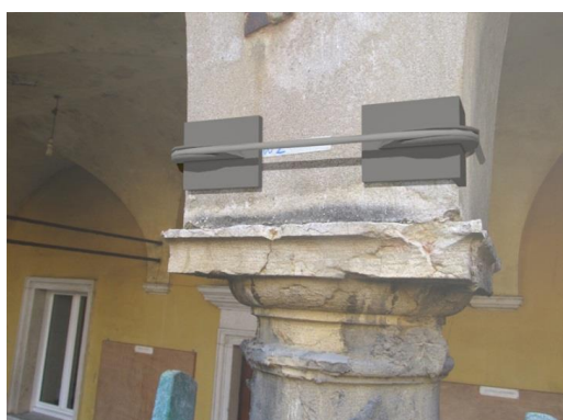
Foto inserimento delle piastre per le nuove catene e particolare delle fasciature in FRP
