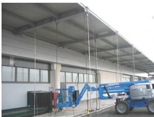
Aeroporto Valerio Catullo (VR): prova di carico su pensilina metallica
