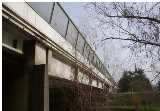
Ponte sul fiume Retrone lungo l’autostrada A4
