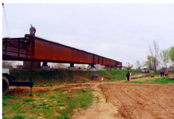
Viadotto sul torrente "Muson dei Sassi": varo dell'impalcato metallico
