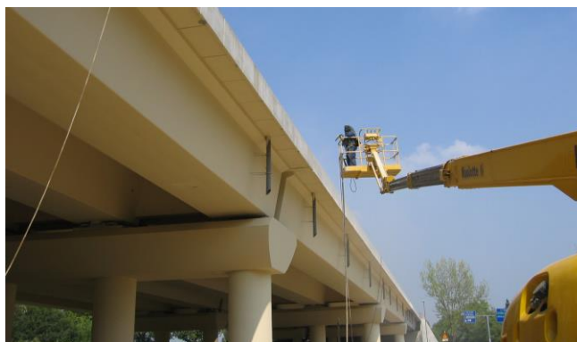
Viadotto “dell’Ospedale” a Treviso: vista parziale dell’impalcato a lavori in corso
