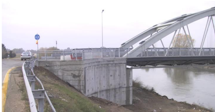
Innesto S.P. 19 sul ponte di Albaredo (VR): fase 1 a lavori conclusi
