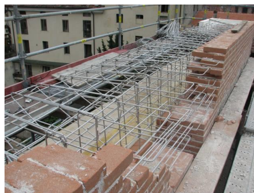
Asilo Rossi di Schio: copertura dopo l'incendio e cordolo in muratura armata
