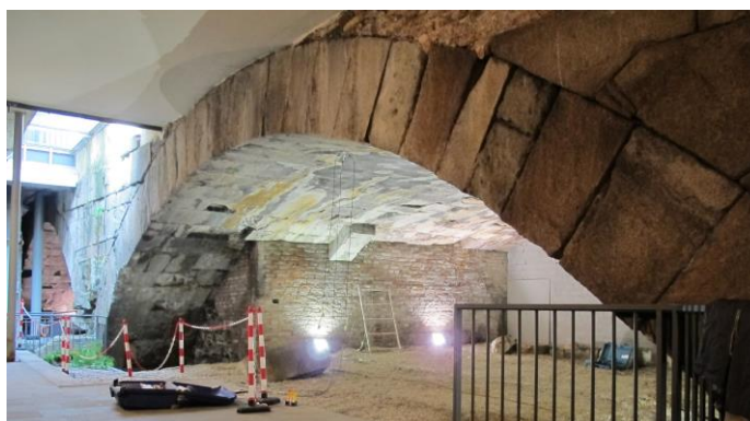
Ponte romano di San Lorenzo a Padova: installazione di sistemi di monitoraggio
