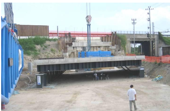
Ponte di Brenta (PD): prova di carico della struttura di copertura della galleria
