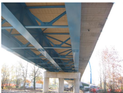
Viadotto di Silea: vista dall'intradosso a lavori in corso e dettaglio di un dispositivo di appoggio e dissipazione sismica
