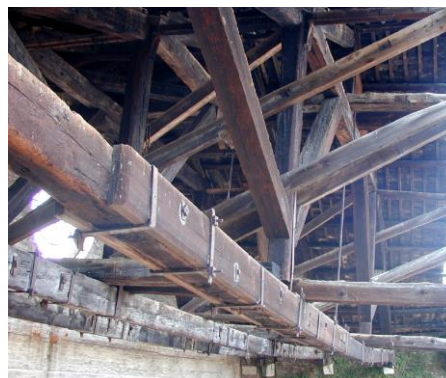
Arsenale di Venezia: vedute della “Tese” e particolare del rinforzo di una capriata lignea
