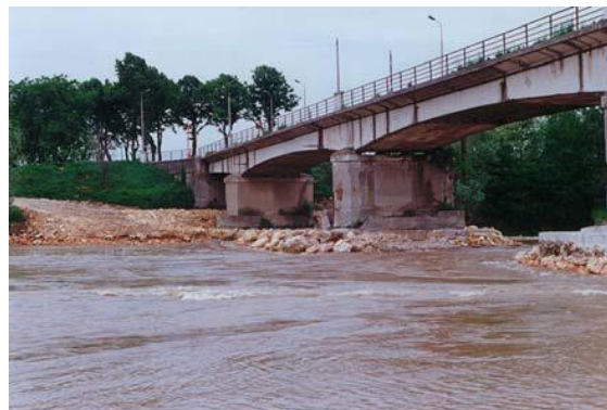
Ponte di Zevio (VR): vista del cantiere in alveo e delle pile a lavori ultimati
