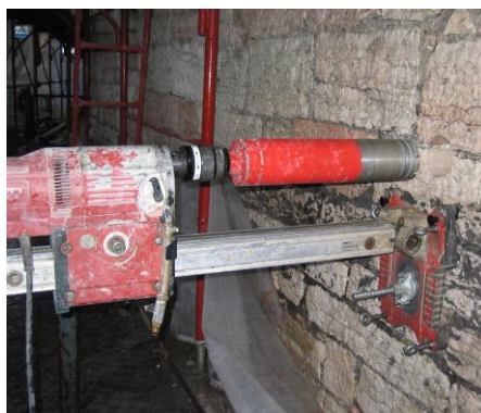
Torre Vanga (TN): modello FEM del manufatto murario, carotaggi sulle murature in pietra e vista a lavori ultimati
