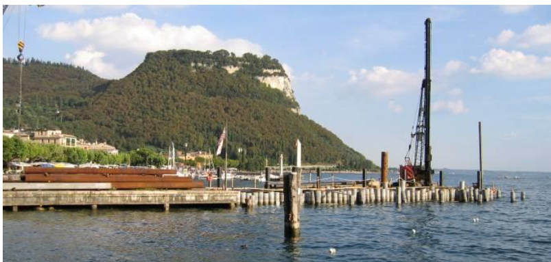
Pontile S. Carlo presso Garda (VR): vista generale del cantiere
