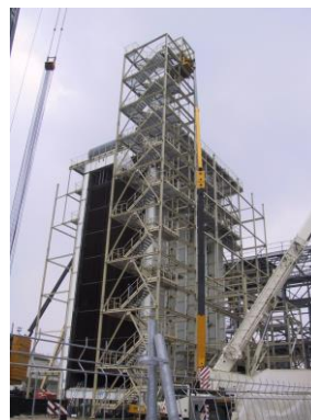
Ponti sul Mincio (MN): vista delle strutture metalliche della centrale, della scala e della ciminiera durante il montaggio
