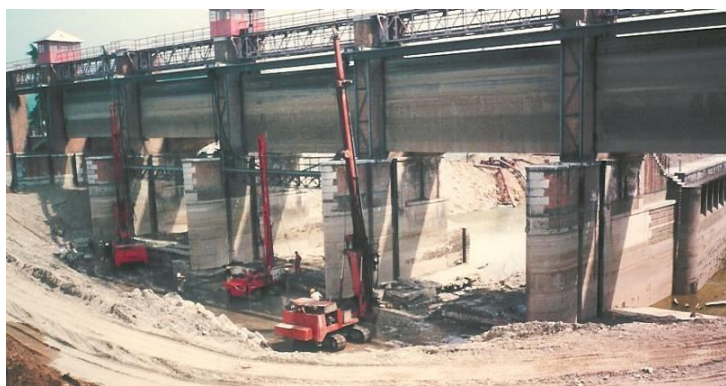
Diga del Chievo (VR): esecuzione delle opere di rinforzo delle fondazioni
